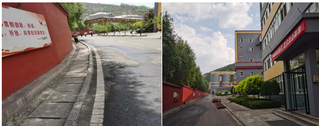
场地内排水沟
