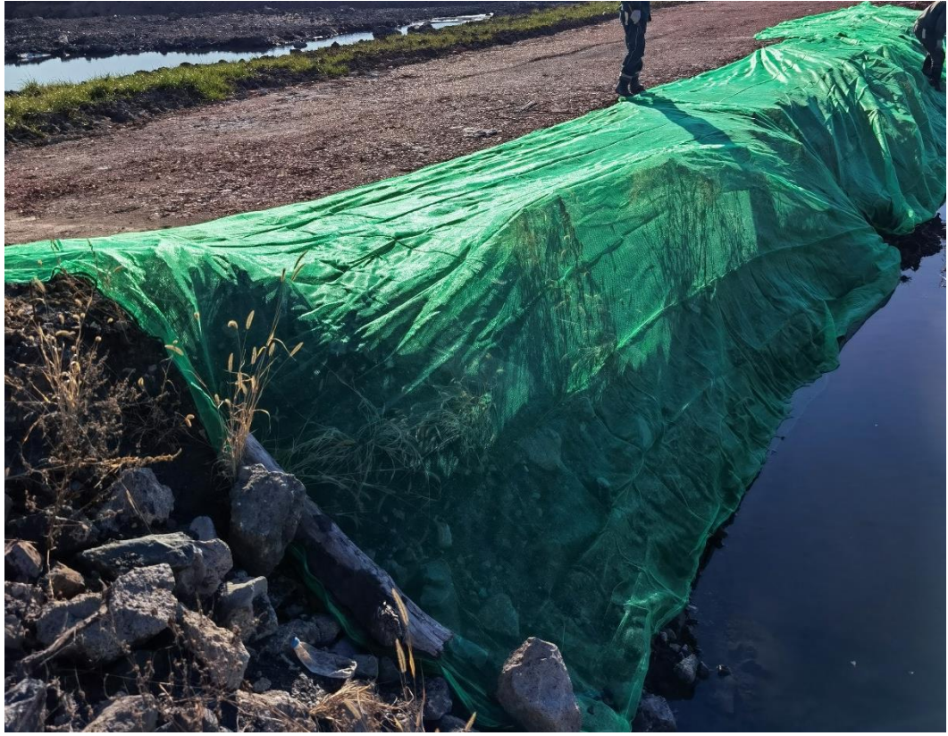
排矸场密目网苫盖
