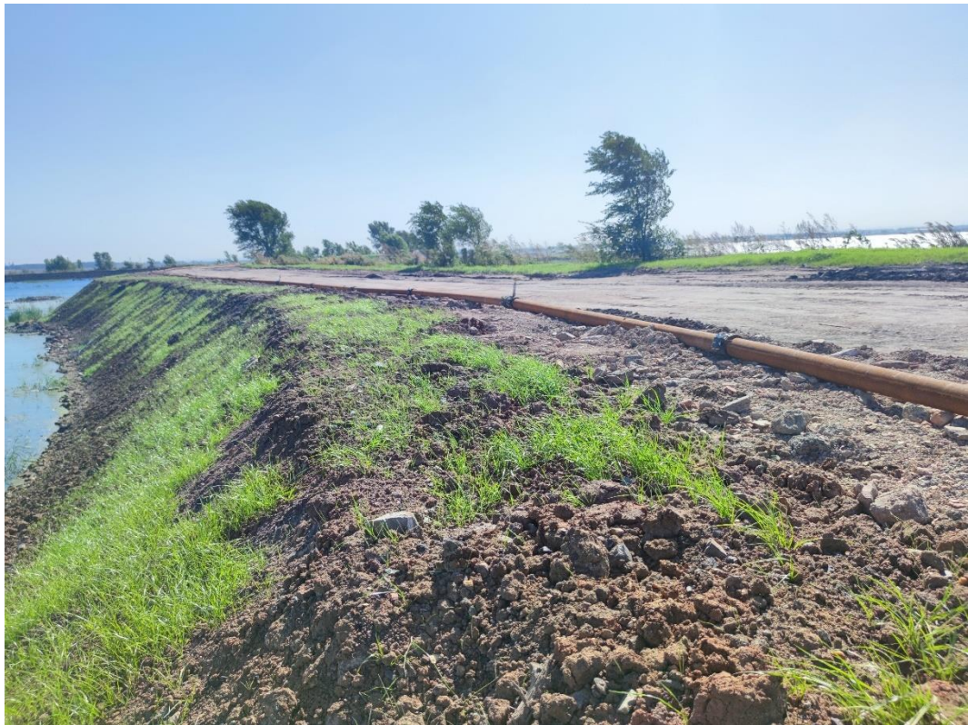
排矸场边坡绿化
