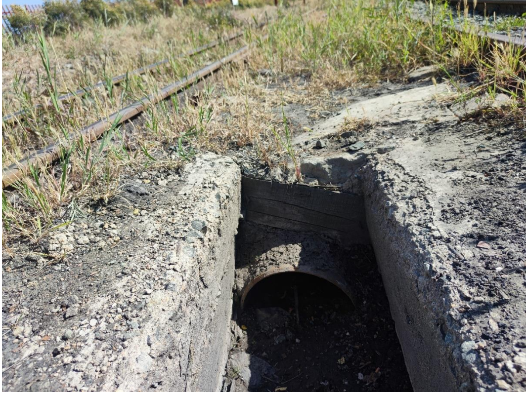
工业场区排水管道
