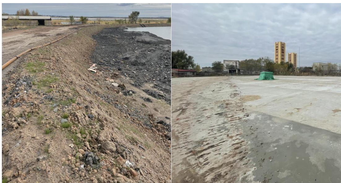
排矸场绿化措施和场地硬化
