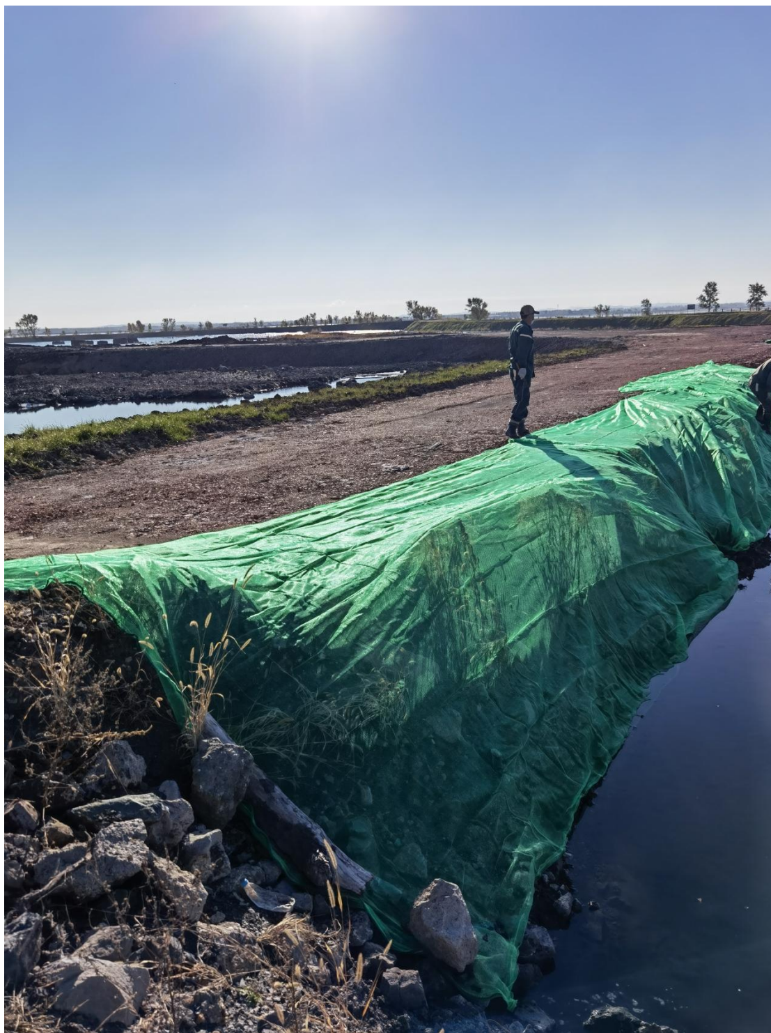
排矸场临时苫盖措施
