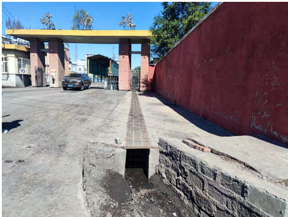
场外道路排水沟
