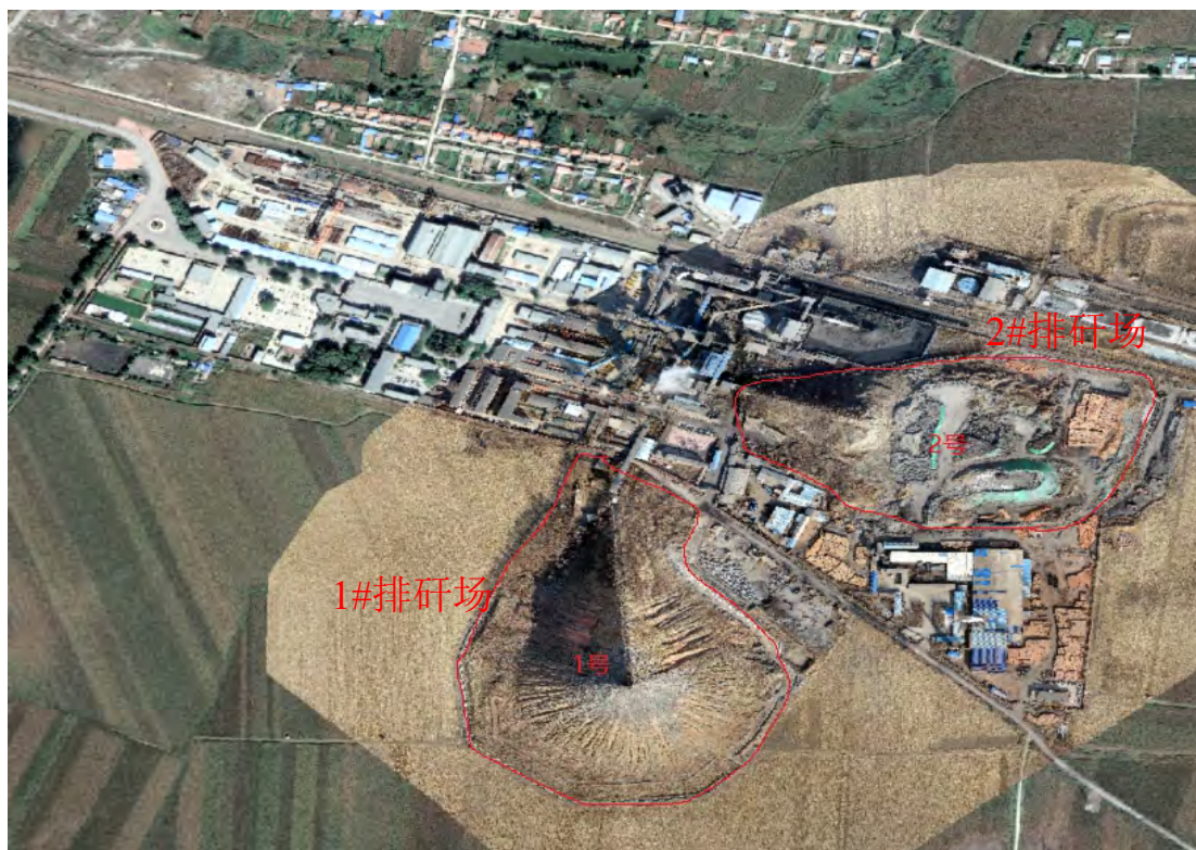
图 3-4 排矸场使用后现场（2023 年）
