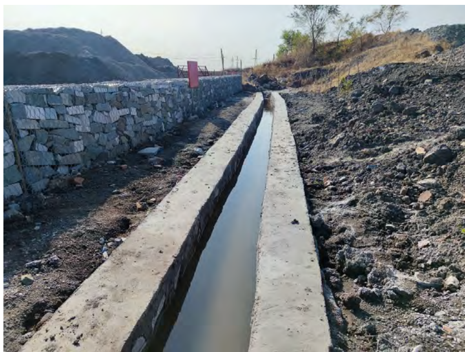
浆砌石排水沟
